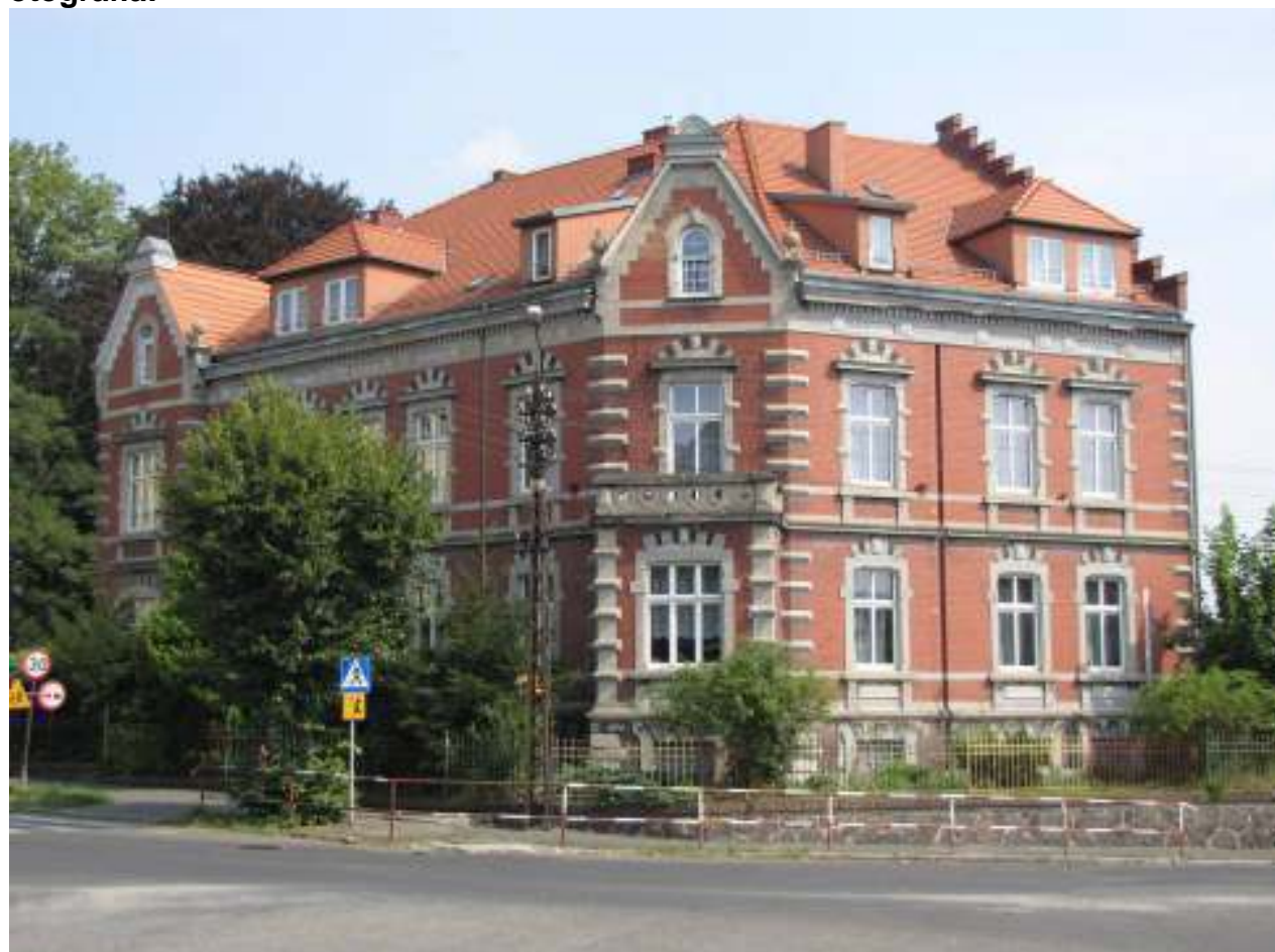
Fot. Elewacja frontowa
